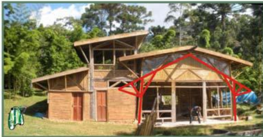
CONSTRUÇÃO DO SALÃO PARA OFICINAS ANEXO AO REFEITÓRIO
